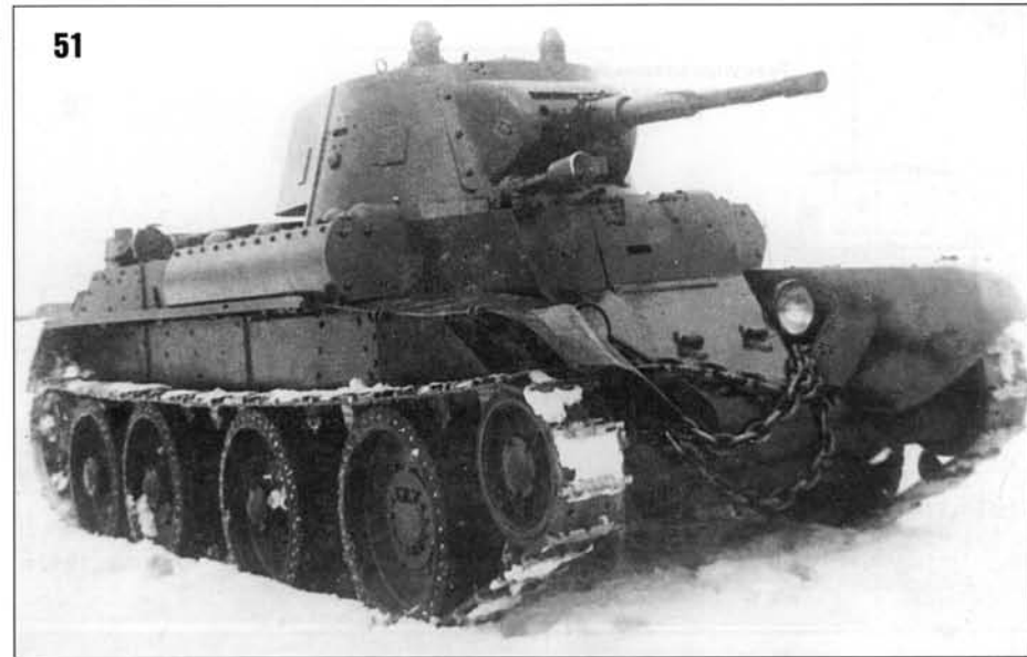
51,52. Огнеметный танк ОТ-7 (ОП-7). Flame-throwing tank OT-7 (OP-7).
