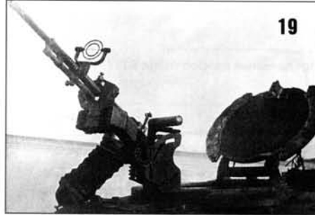
19. Зенитная установка 7,62-мм пулемета ДТ (П-40). DT (P-40) 7,62 mm AA machine gun installation.
