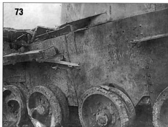
72-75. Наиболее характерные боевые повреждения танков БТ-7, полученные во время боев на р.Халхин-Гол. The most typical battle damages of BT-7 tanks received in action at Khalhin Gol border conflict.
